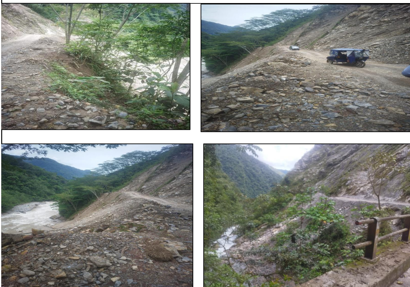
FIGURA N° 01: SE EVIDENCIA SOCAVACION Y EROSIÓN POR CRECIDA DEL RÍO HUANCABAMBA, PONIENDO EN RIESGO LA VIA DE TRANSITO DE POZUZO A OXAPAMPA
